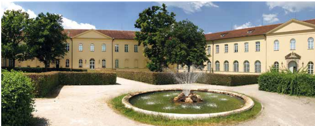
Im Bestandsbau, in dem sich jetzt das Museum Mensch und Natur befindet, werden langfristig die Verwaltung und Werkstätten von BIOTOPIA untergebracht sowie die Gastronomie.
